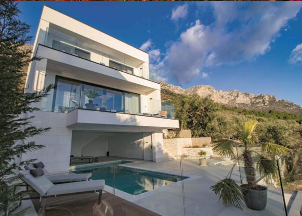
044 Rekonstrukcija stambene građevine, Podaca
