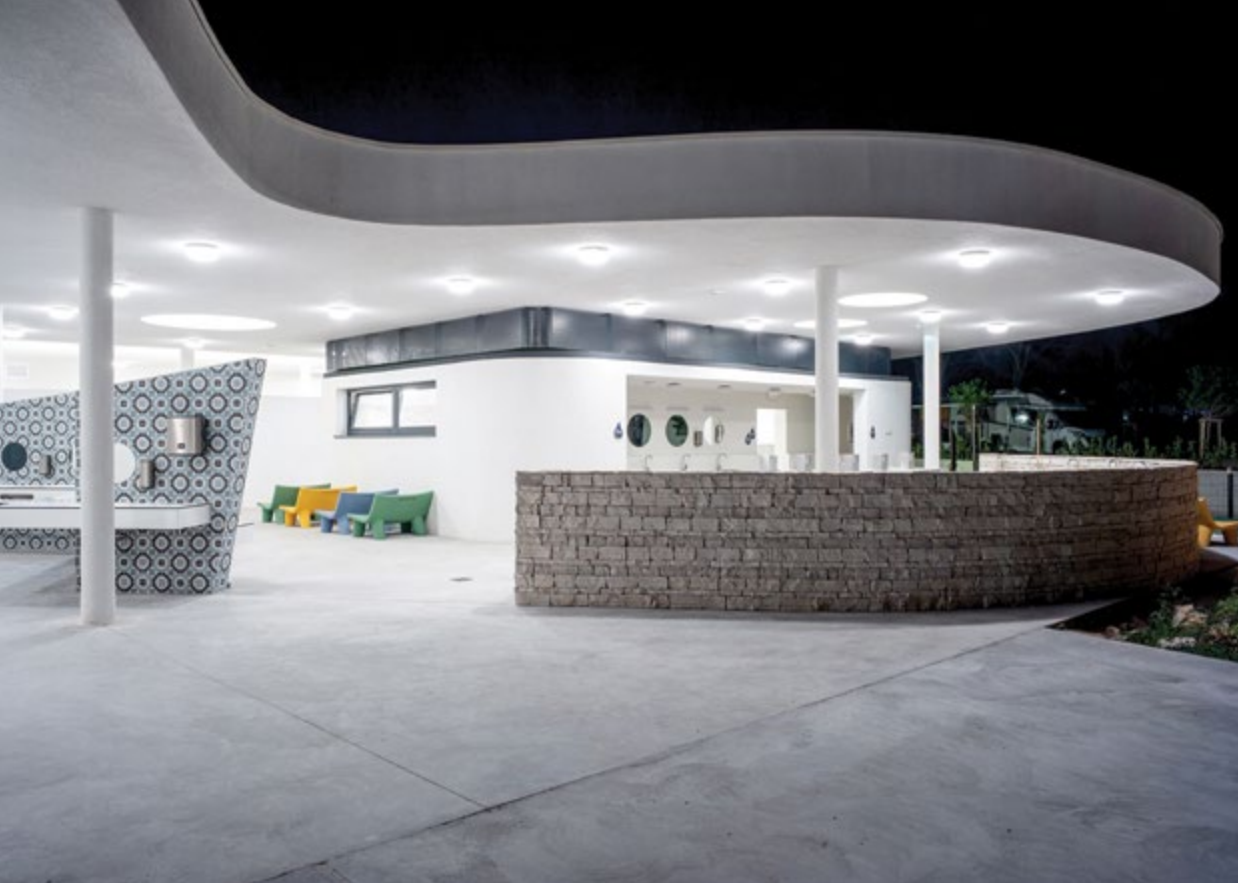
055 Zadarska trilogija – Kamp Borik – Sanitarni blok
