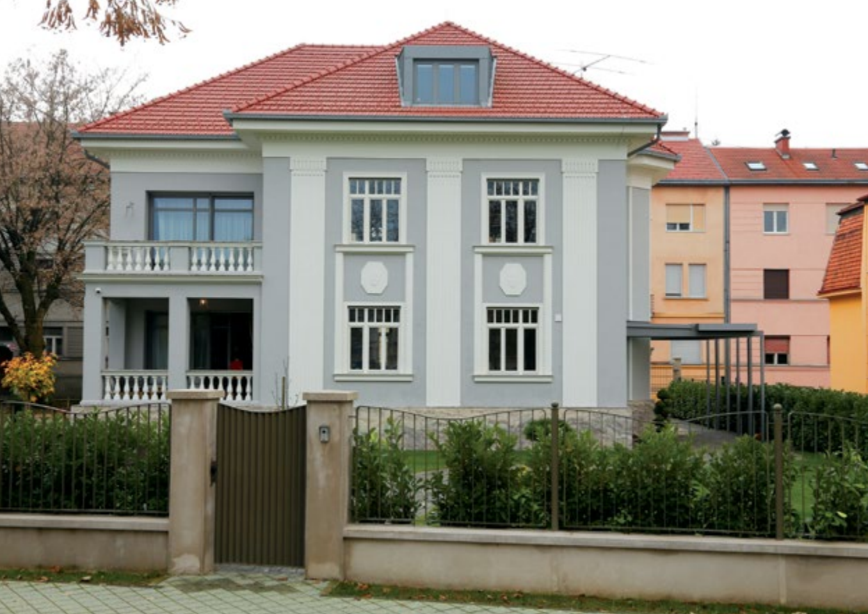
075 Rekonstrukcija postojeće vile u Karlovcu
