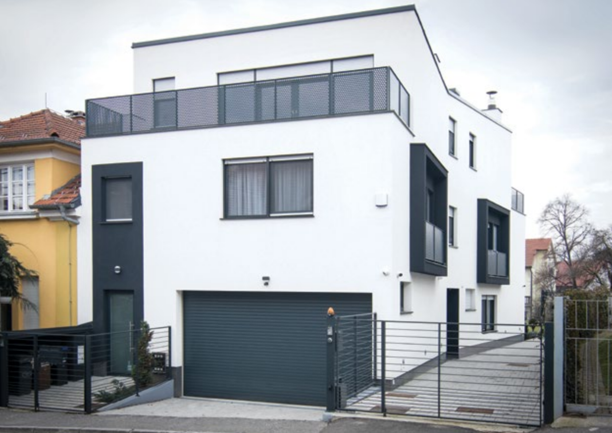
027 Stambena zgrada s tri stana
